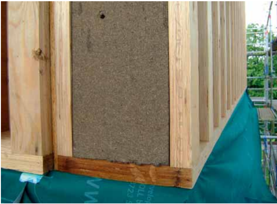
De houtskeletbouw-isolatieschil: uitgelijnd op een muurplaat in LVL staan de I-liggers in het gelid.
