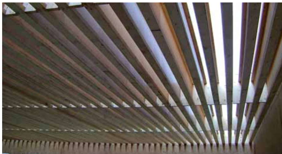
De roostering met I-liggers. (foto's en doc.: arch. Alexis Versele)
