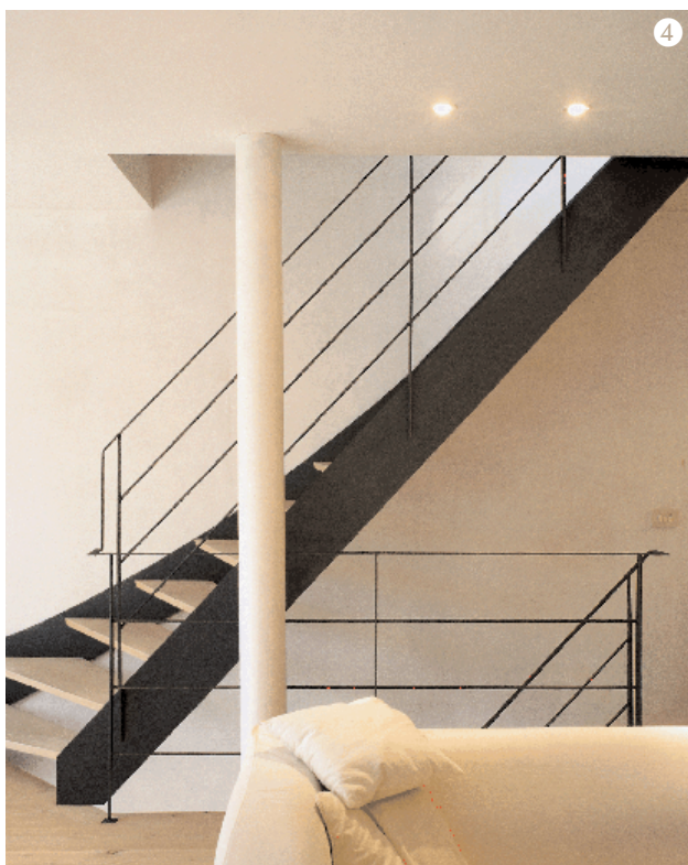
4 Een houten trap met stalen trapbomen circuleert vanuit de eethoek doorheen de zithoek naar de slaapkamers.
