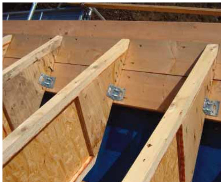
Indien de dakconstructie wordt gerealiseerd met houten samengestelde lbalken van 300 mm in plaats van massieve balken van 225 mm dan krijgen we een U-waarde kleiner dan 0,15 W/m 2 K
