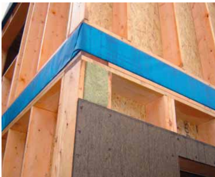
De koudebrugwerking veroorzaakt door de houten balken van de houtskeletwand of van de dakconstructie kan worden verminderd indien aan de buitenzijde van de wand of het dak een isolerende isolatiebeschermlaag wordt aangebracht
