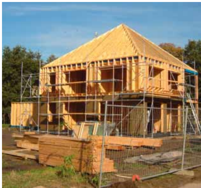
Dampopen houtskelet in aanbouw volgens de passiehuisstandaard. In deze constructie kan geen vocht ingesloten worden
