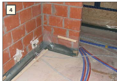
1. Binnenafwerking met dubbele laag dampopen houtvezelisolatieplaten; 2. Buitenaafwerking met een pleisterlaag 3. Cellenbetonblokken met vochtscherm; 4. Het leidingentracé kon tot een minimum beperkt worden
