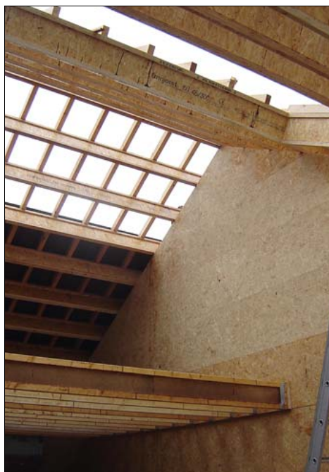
Voor het hellend dak werden Higgers van 300 mm als gordingen op een afstand van 50 cm geplaatst
