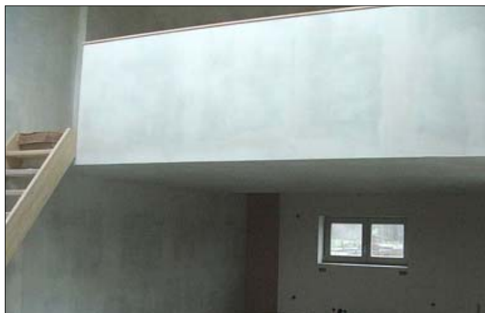
De niet-geïsoleerde dakstructuur van de bestaande woning werd verwijderd en opgetrokken zodat ook een open mezzanine gecreëerd kon worden
