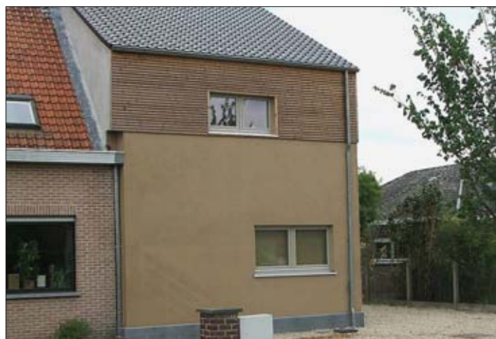
De gevel werd onderaan afgewerkt met een silikaatpleister en ter hoogte van de bovenverdieping met een beplanking van thermisch behandelde grenen
