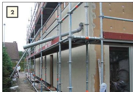
1. Binnenafwerking met dubbele laag dampopen houtvezelisolatieplaten; 2. Buitenaafwerking met een pleisterlaag 3. Cellenbetonblokken met vochtscherm; 4. Het leidingentracé kon tot een minimum beperkt worden
