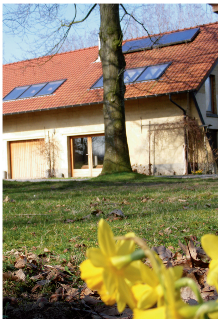
Op het dak bevindt zich ook een zonneboiler van zes vierkante meter.
